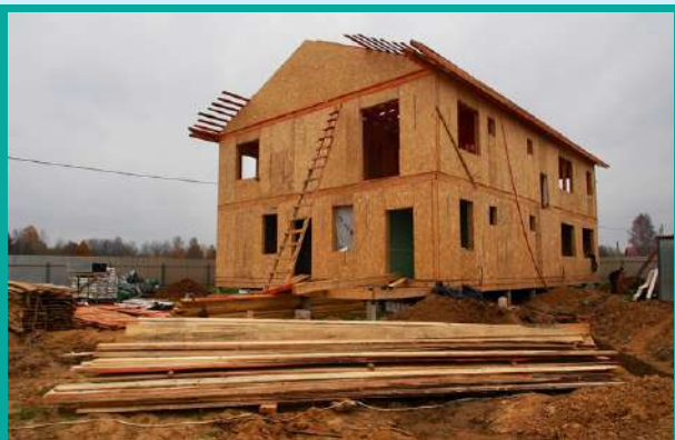
2018 год: Начато строительство двух домов в экодеревне Семеево
